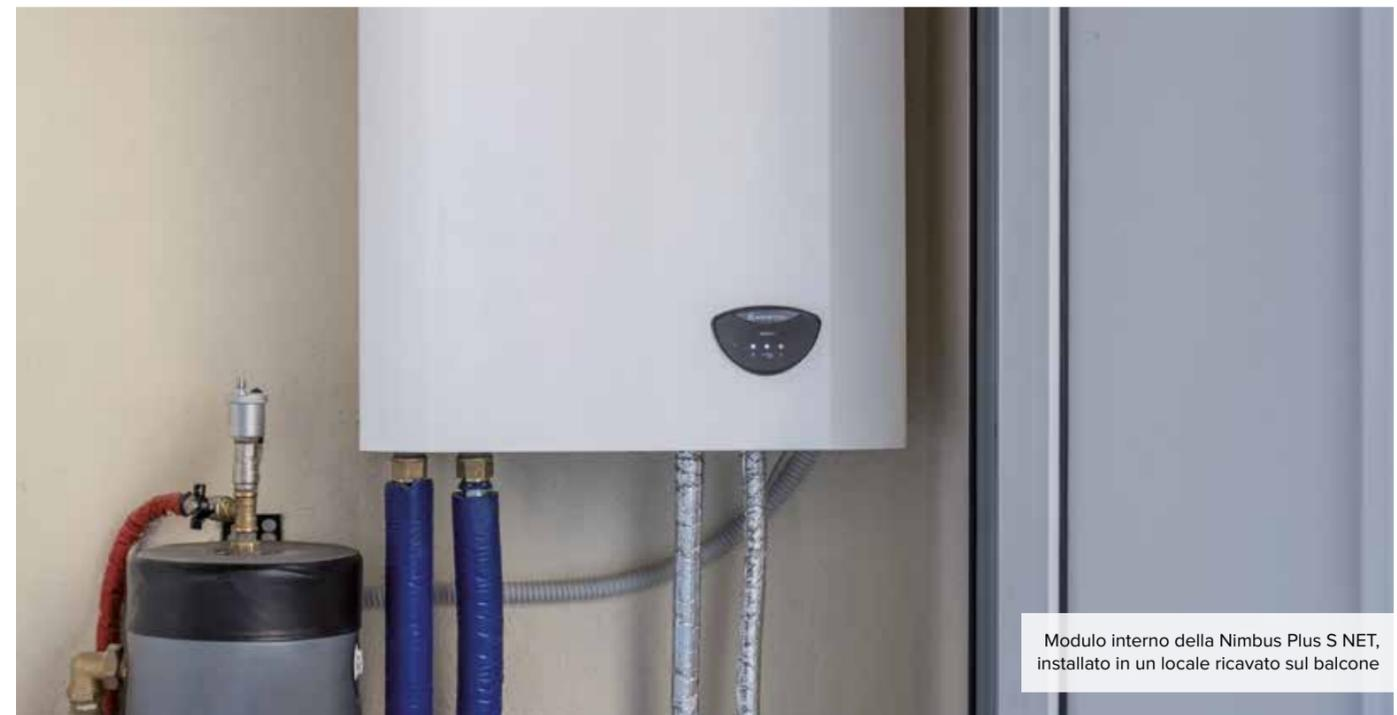
Modulo interno della Nimbus Plus S NET, installato in un locale ricavato sul balcone
