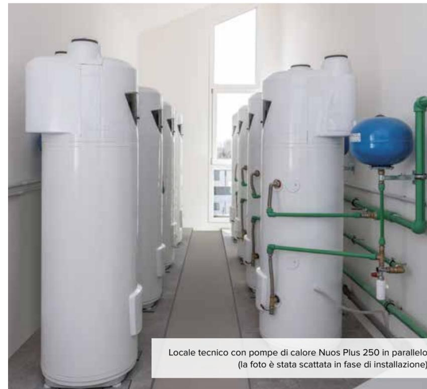
Locale tecnico con pompe di calore Nuos Plus 250 in parallelo (la foto è stata scattata in fase di installazione)
