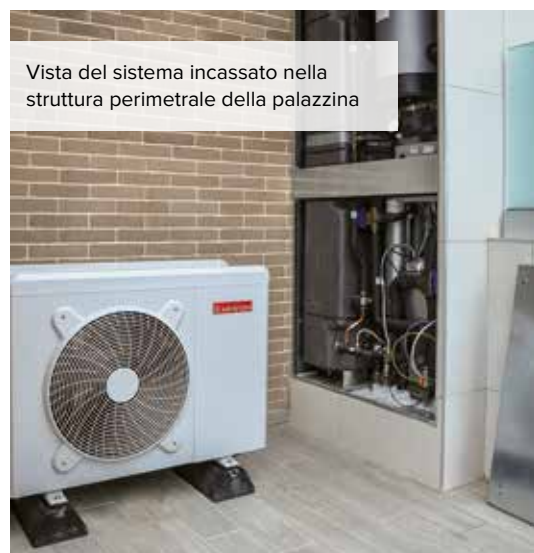
Vista dell'unità esterna collocata nello spazio adiacente l'abitazione
