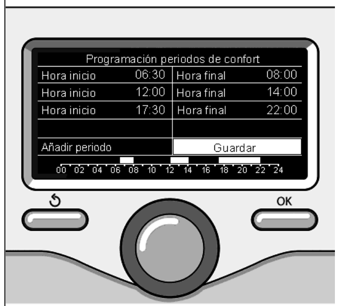
Programar períodos confort programación horaria calefacción
